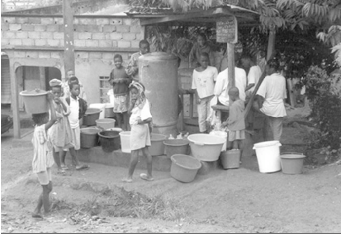
Photo 3 : Borne fontaine installée par une association de quartier.
